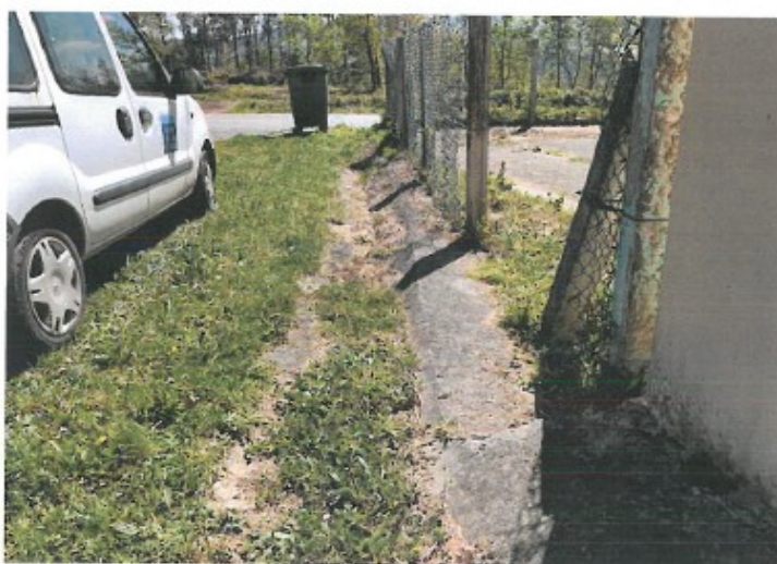
RENOVACIÓN DE GABIA REVESTIDA CON PREPARACIÓN DUN ACCESO ACCESIBLE
